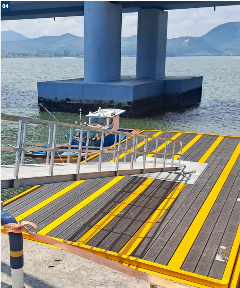
03 경남 사천시 비토항 PE 부잔교 설치공사 주요기관 사천시 설치장소 경남 사천시 비토항 설치일자 2022년 06월
